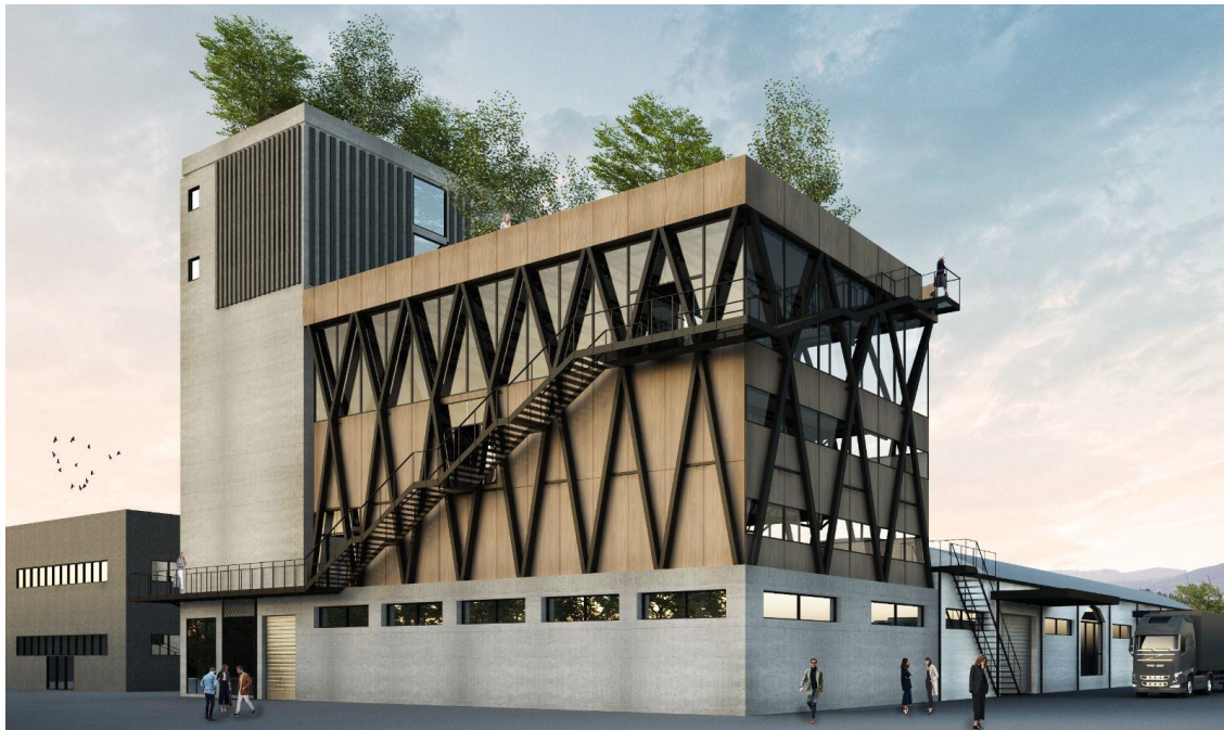
Il nuovo building in costruzione della sede di Idee Consulting S.r.l. – Scandicci (Firenze)
